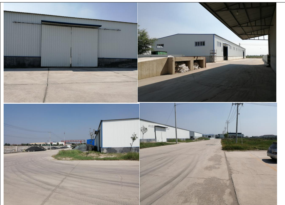
图3-5 厂区道路均已硬化
